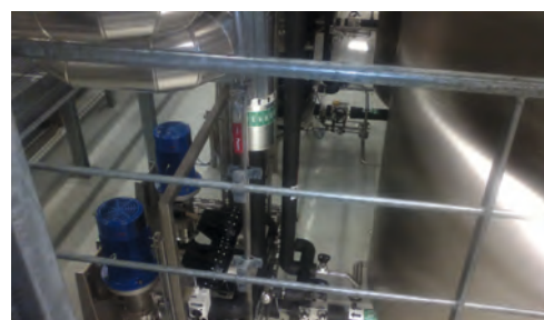
Илл. 4: Изоляция горячих емкостей и трубопроводов и их расположение в системе получения чистых сред
