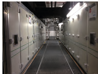
Илл. 1: При планировании систем кондиционирования важно принимать во внимание стоимость жизненного цикла (все иллюстрации: Becker Reinraumtechnik)
