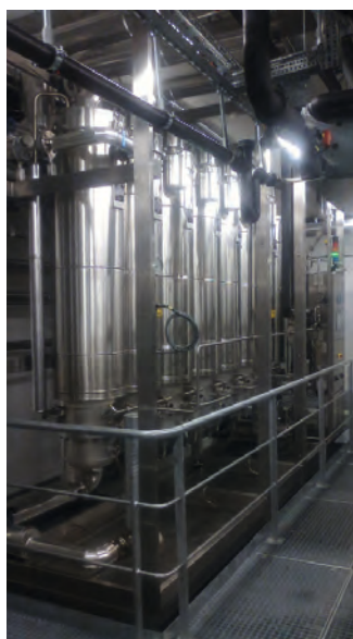
Илл. 4: Изоляция горячих емкостей и трубопроводов и их расположение в системе получения чистых сред
